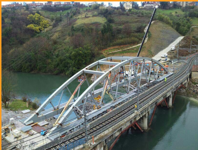
Sustitución del puente del topo sobre el Urumea y demolición del puente-colector de Añarbe
